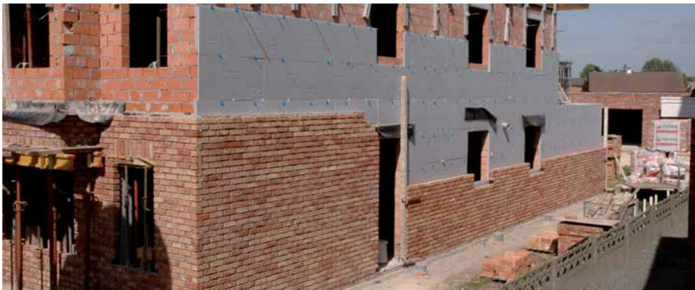
SlimFort : panneaux d'isolation pour systèmes de façade fermés avec parement sec ventilé, pour pose horizontale ou verticale, en construction neuve ou en rénovationl.
